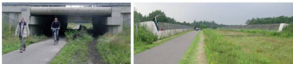
Links: Passage „Zevenbergen“ bei Nistelrode. Rechts: Brücke „Slabroek“ bei Uden (GIULIO & SCHLUP 2008).
